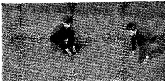
Рис. 131. Вычерчивание окружности веревкой
